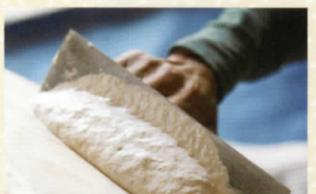
干潟で名高い有明海。「幻の漆喰」はその海に生息する赤貝の殻を焼いた焼成カルシウムに海藻を煮て作る糊と無菌水を混ぜ合わせ、生成されます。自然素材しか使っておらず、人体にも無害で安全。さらに独自の「光熱触媒」作用により、室内の化学物質を吸着・分解し、住まいの空気をいつまでも清浄に保ちます。
